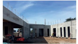
La nouvelle école prend forme. L'entreprise « Guicheteau » termine l'assemblage des structures béton. Le charpentier et les étancheurs se coordonnent pour l'élaboration de la couverture. La prochaine étape, dans les jours à venir, sera l'arrivée des plaquistes, des réseaux fluides et électriques.
